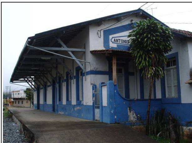
2) Estação Ferroviária. Vista externa. Fachada posterior.
