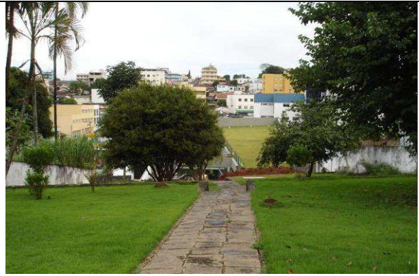
3) Casarão Magalhães Pinto. Vista externa: quintal, anexo sendo construído aos fundos, e entorno em processo de verticalização. Foto: Nívia Raquel. Março/2009.
